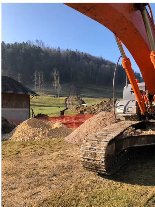
Travaux d'excavation pour le raccordement de Lucelle aux réseaux d'eau potable et d'électricité (Commune de Pleigne).
