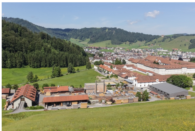
L'abbaye d'Einsiedeln avec son installation thermique (Birchler Architektur AG, Einsiedeln).
