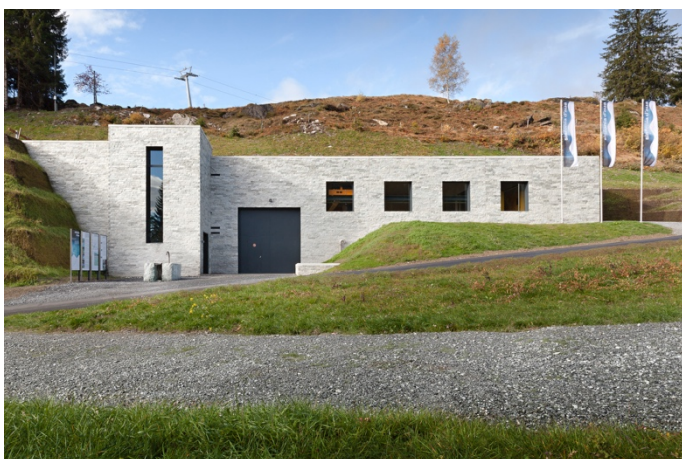
Centrale hydraulique et énergétique de Punt Gronda (Flims Electric AG).
