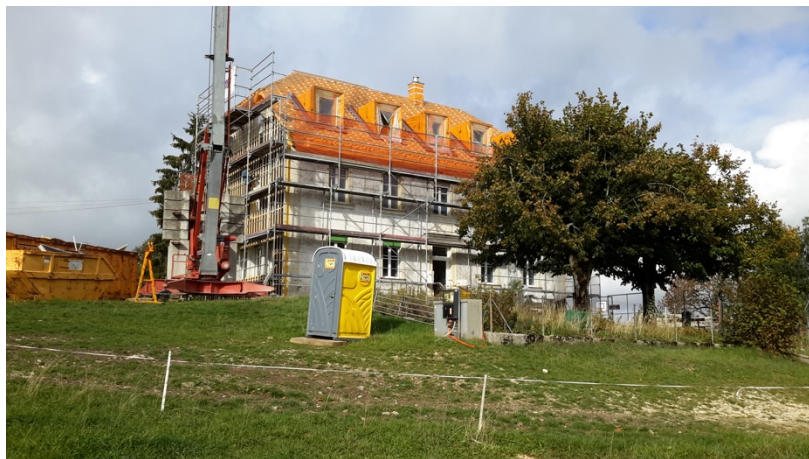
Rénovation de l'école des Enfers (Commune de Pleigne).
