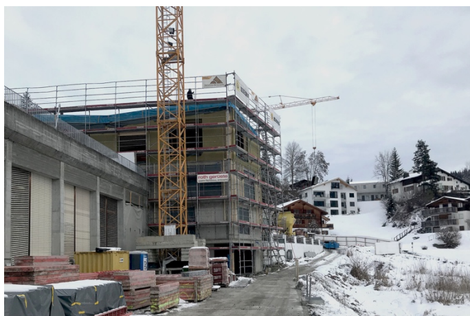
Assainissement de la piscine couverte à Laax et construction de la nouvelle auberge wellness (SSA Architekten).
