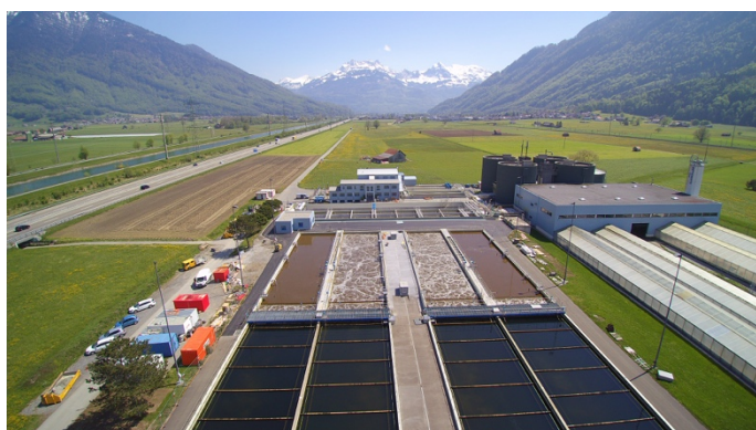
Vue de la station d'épuration de Bilten (Abwasserverband Glarus).
