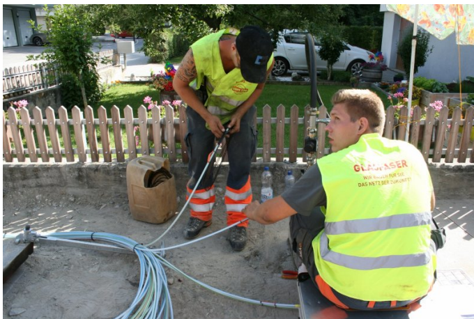
Installation du réseau de fibres optiques dans le Haut-Valais (DANET AG).
