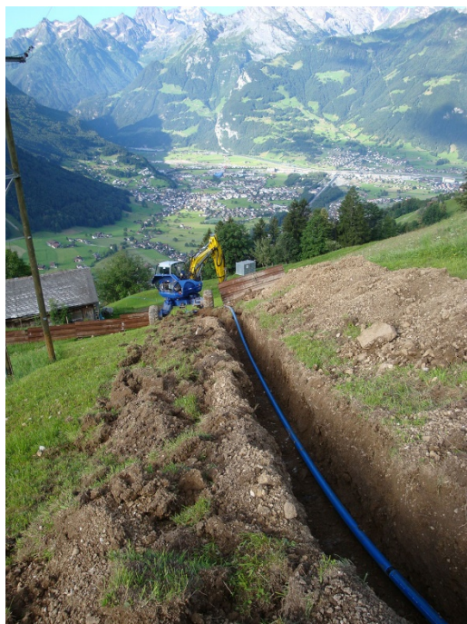
Pose des nouvelles conduites d'eau sur l'Eierschwand ( eierschwand.ch ).
