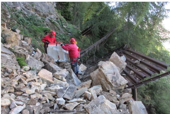
Mise en place de pare-avalanches dans les environs de Loèche-les-Bains (Forst Region Leuk).
