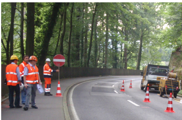
2 Le port de vêtements de signalisation à haute visibilité de classe 2 (torse couvert) est également nécessaire en cas de séjour de moins d'une heure sur la voie publique (p. ex. pour un contrôle de chantier, une visite des lieux).
